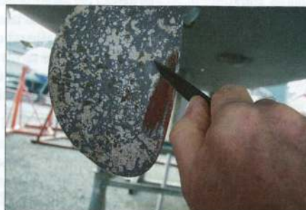
▲ De la corrosion en surface n'est pas inquiétante tant que l'on retrouve le bronze en grattant.
