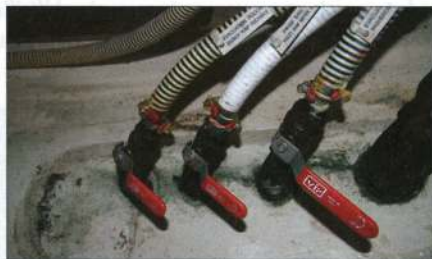
▲ Idéalement, il faut inspecter toutes les vannes qui doivent se manipuler aisément.
