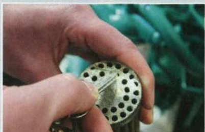
▲ Le nettoyage régulier de l'échangeur n'est pas à négliger pour éviter l'obstruction.
